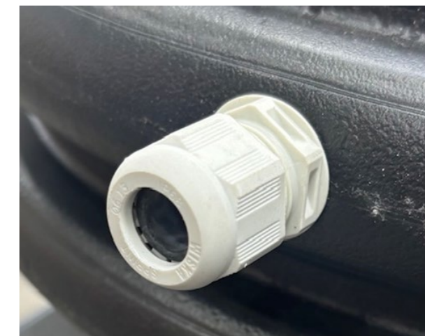
Przyłącze na przewód do pompowni
