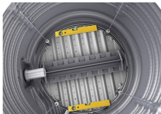
Sprawdzanie ustawienia systemu rozdzielającego.
