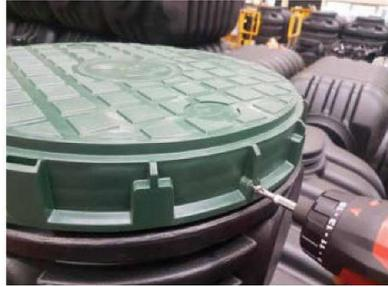
2. Colocar los tornillos INOX 4,8x32 en los orificios de la cubierta y apretarlos.
