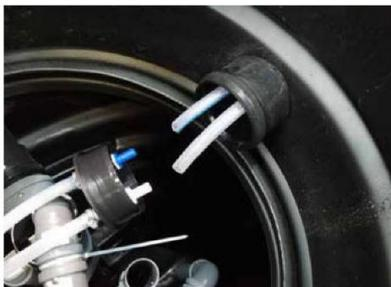
1. En primer lugar, se debe introducir el conjunto de mangueras en el interior del realce a través de las conexiones técnicas.
